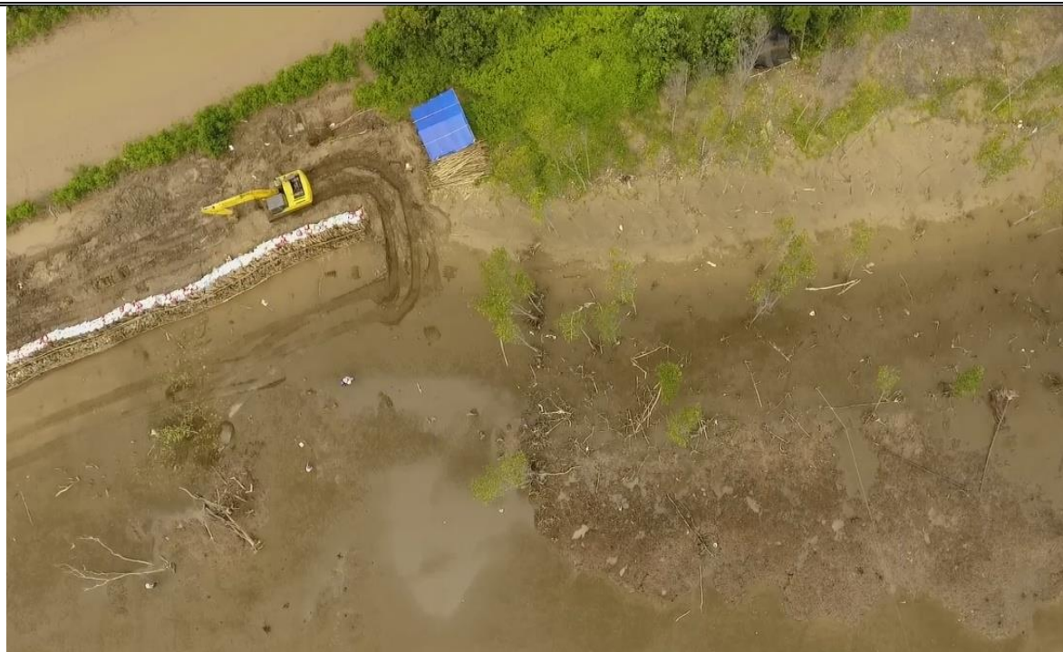
Hình 6.2: Xói lở nghiêm trọng tại khu vực K44, xã Vĩnh Hải, Vĩnh Châu
