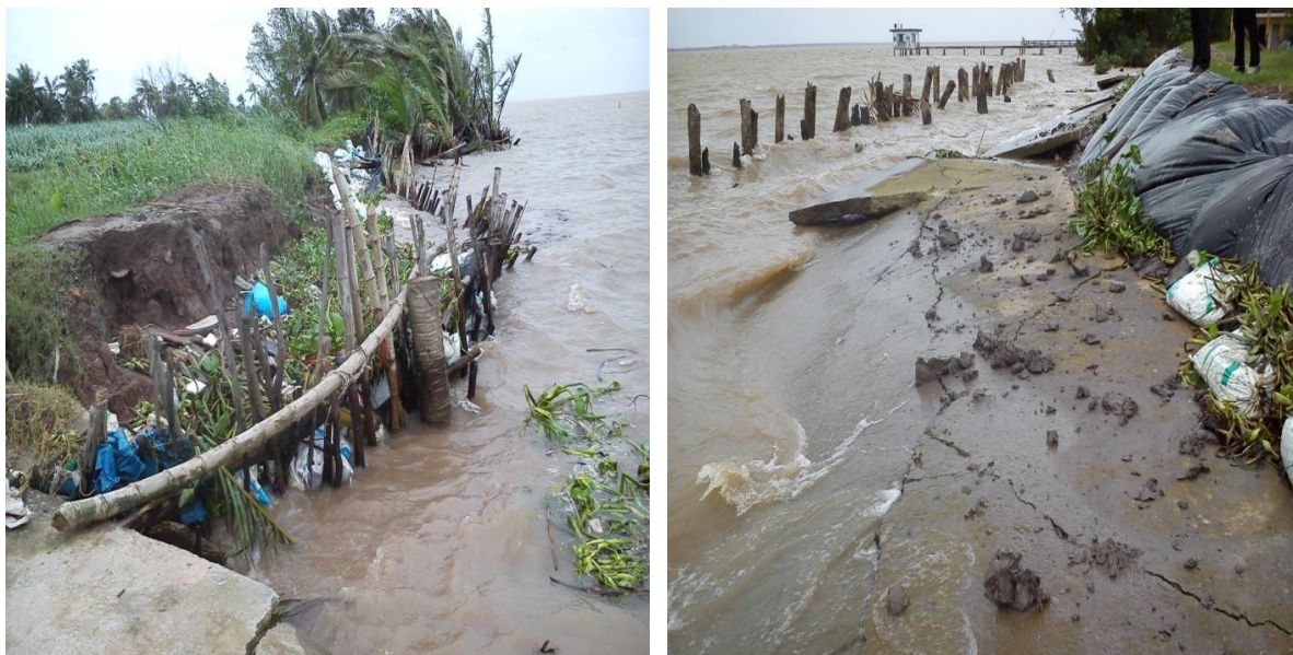
Hình 6.7: Sạt lở tại xã An Thạnh 3
